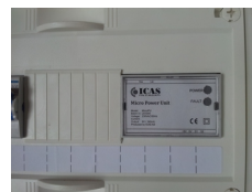
Power m/backup uPU: monterat i el-skåp eller på vägg
